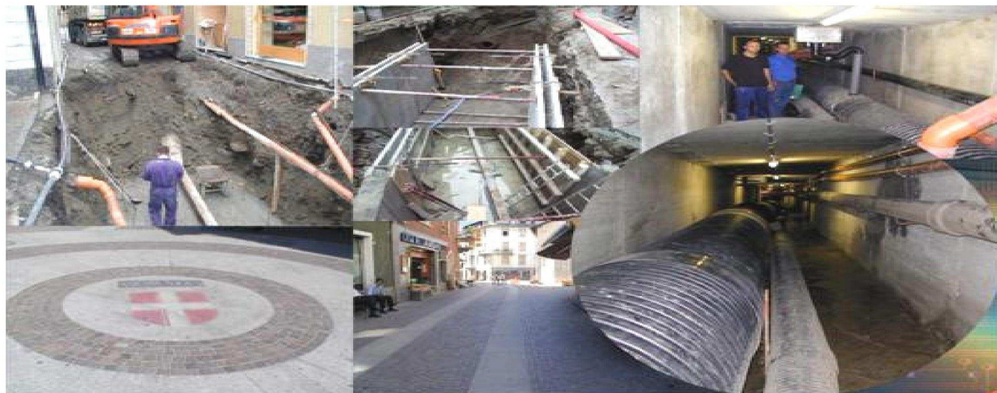
Realizzazione del tunnel tecnologico, Comune di Bormio in via Roma
